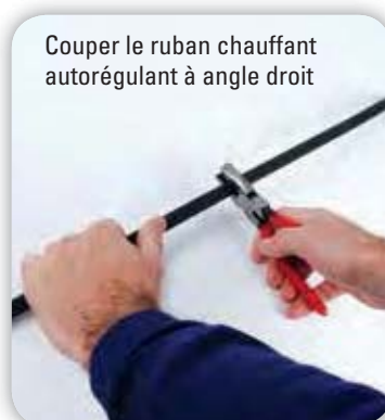
Rayon de courbure minimum : 30 mm
