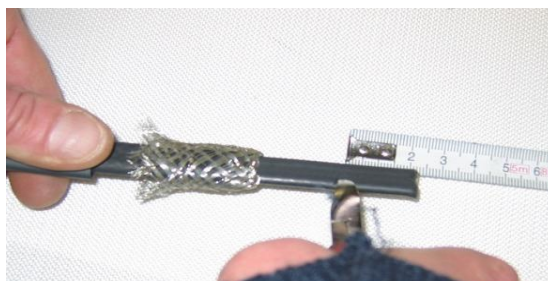
4) Recouper le cable chauffant de 25mm
