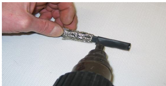
6) Chauffer pour rétracter
