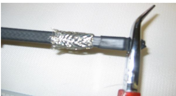
7) Pincer et écraser l'extrémité du manchon encore chaud à l'aide d'une pince plate.
